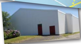
Nouveau bardage sur la salle Jean Tanguy
