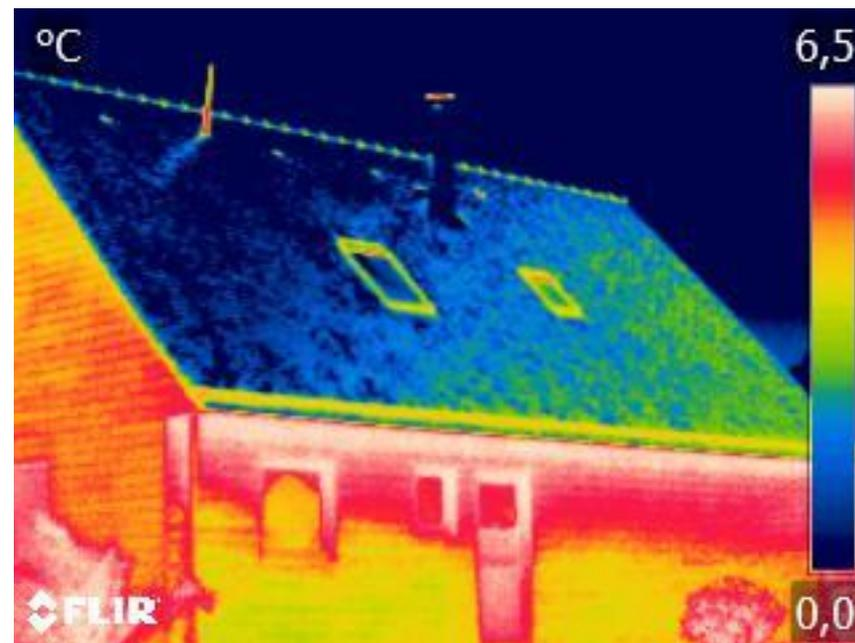
Pont thermique du plancher intermédiaire
