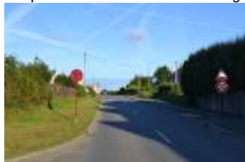
Des aménagements de voirie sécurisant la circulation dans le cœur du village
