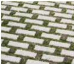
Pavage en béton avec ouvertures de drainage
