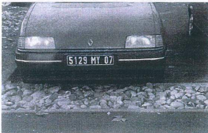
Tranchée d'infiltration des eaux pluviales sur un parking à Lyon ; photo S. Barraud, INSA Lyon.
