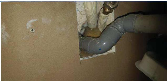
**Type :** D3-Traversée de plancher et de murs et/ou cloisons (tout type de plomberie, conduits et gaines électriques...)
