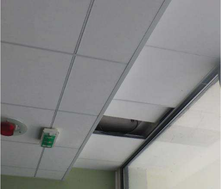
Illustration N°2 : Primaire – dalle toiture terrasse non isolée en faux plafond – faiblement isolée par le dessus sans doute.
