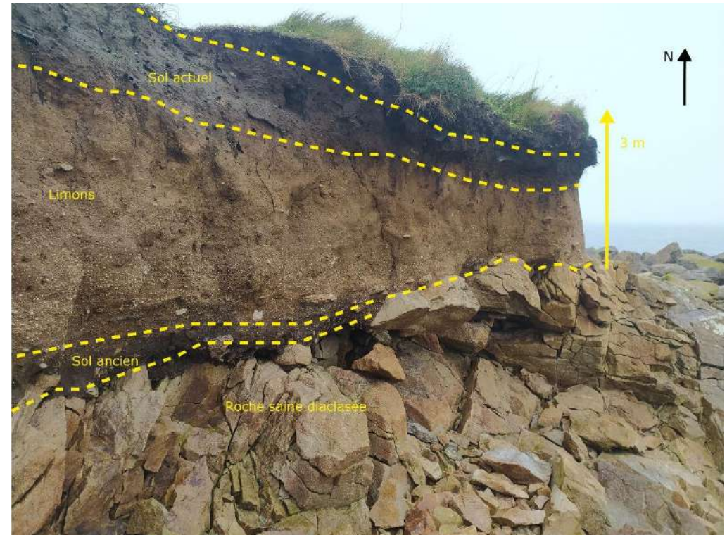
Figure 17 - Falaises meubles constituées d'un sol ancien, de limon et d'un sol actuel à son sommet, St-Michel (16/01/2021)
