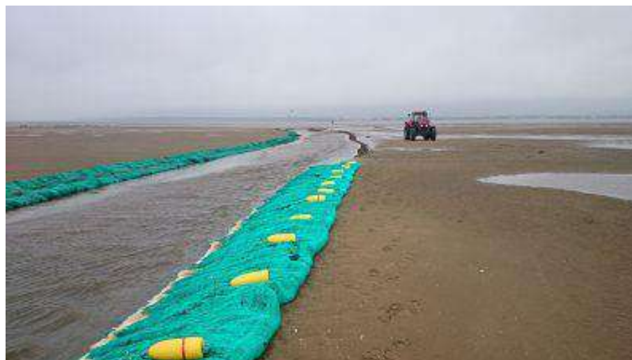
Figure 87 - Dispositif "S-ABLE" ( https://www.energiesdelamer.eu/ )
