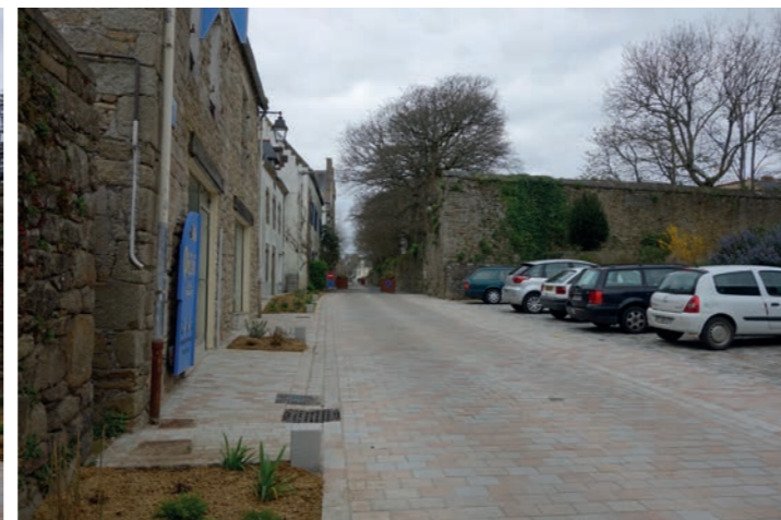
Pont-Croix (29) - La circulation des véhicules, les espaces piétonniers et de stationnement sont réalisés en pavés de granit au même niveau. Seule la mise en œuvre permet de différencier les espaces : sens de poses des pavés, joints enherbés pour les stationnements. Revitalisation du centre-bourg - PLOUGUERNEAU
