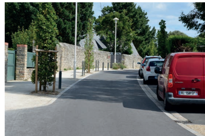
Combrit (29) - Sur un même niveau, l'espace piétonnier est réalisé en béton désactivé beige, la chaussée en bitume noir et les places de stationnement séparées par un caniveau en pavés de béton beige.
