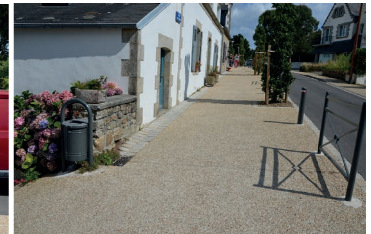
Combrit (29) - Sur un même niveau, l'espace piétonnier est réalisé en béton désactivé beige, la chaussée en bitume noir et les places de stationnement séparées par un caniveau en pavés de béton beige.
