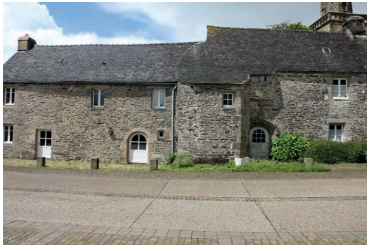
La Martyre (29) - La circulation des véhicules (dalles de béton désactivé) est de plain pied, les espaces piétonniers et de stationnements sont réalisés en pavés de granit.
