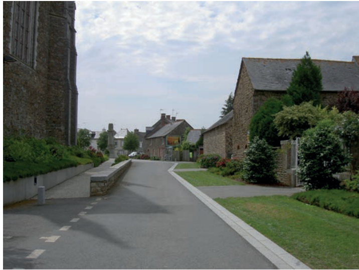
Erbré (35) - La circulation véhicules et piétons (bitume gris) se fait de plain pied, une rigole pour les eaux pluviales (dalles granit) sépare les stationnements en terre pierre qui apportent de la végétalisation lorsque les voitures ne sont pas stationnées.
