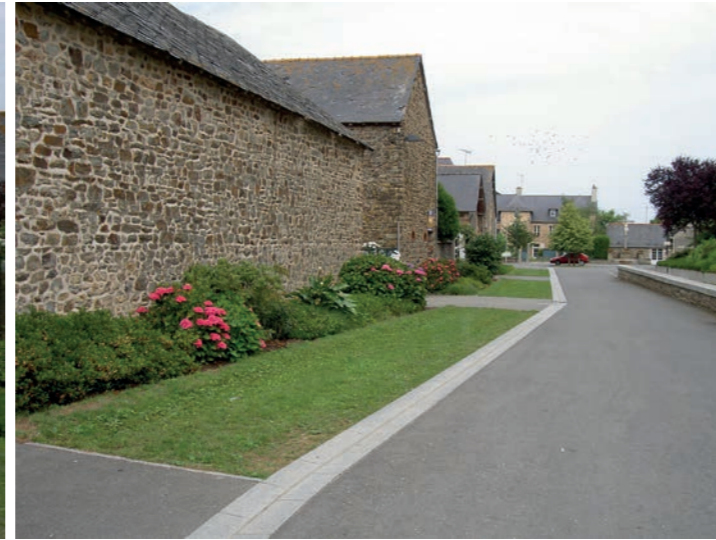
Erbré (35) - La circulation véhicules et piétons (bitume gris) se fait de plain pied, une rigole pour les eaux pluviales (dalles granit) sépare les stationnements en terre pierre qui apportent de la végétalisation lorsque les voitures ne sont pas stationnées.
