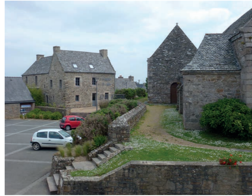
Guimaec (29) aménagement centre-bourg - Alain Le Scour architecte L'espace central est aménagé de façon très sobre avec un carroyage de pavé granit, induisant de façon subtile l'emplacement des véhicules. Ce système engage à limiter la vitesse de circulation et permet de recréer une place fonctionnelle pour tous les usagers, voitures et modes doux.
