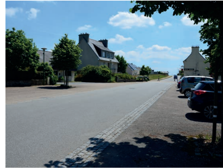
Saint-Divy (29) - Sur un grand espace partagé, les fonctions se côtoient : circulation, espaces verts, stationnement. La chaussée est en bitume gris, des pavés de granit la sépare des stationnements sur du béton désactivé. Des cheminements en pavés de granit permettent de passer au travers des espaces engazonnés.
