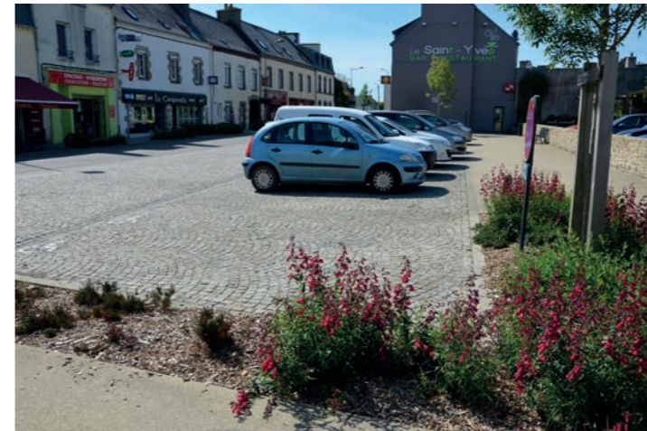
Ploudaniel (29) - La chaussée est réalisée en bitume de couleur grise et beige pour les passages piétons. Les stationnements, en continuité sont réalisés en pavés de granit gris et les trottoirs en béton désactivé.
