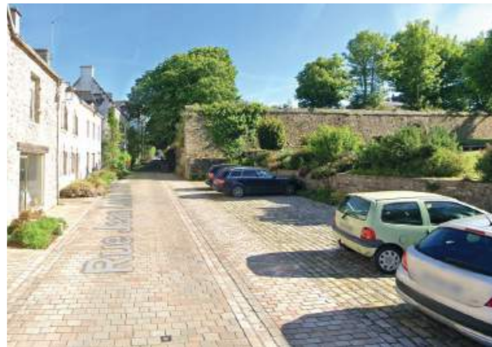
Aménagement en pavé de granit à Pont Croix
