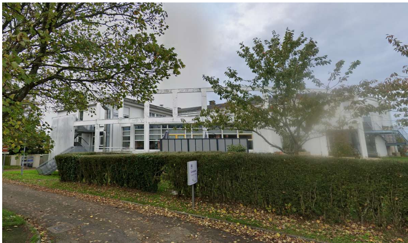
Etat actuel du bâtiment https://www.google.fr/maps/
