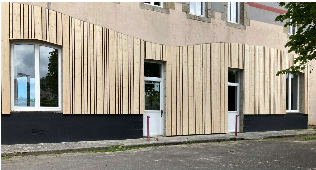
Travaux d'embellissement de la maison communale, réalisés en régie Crédit : commune de Plouguerneau
