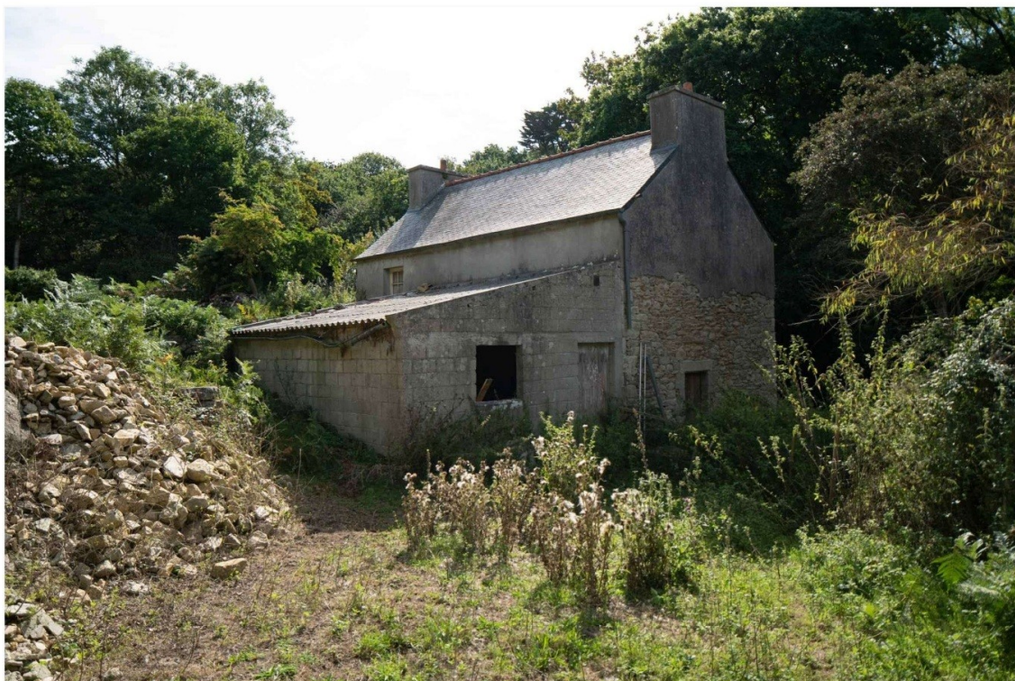
PA7 - Environnement proche de la maison
